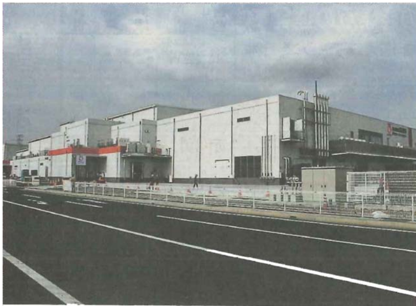
開設される「群馬フローズンファクトリー」 の建物＝太田市吉沢町
