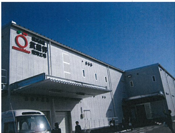
東海工場の外観
