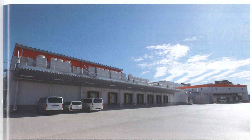
東武東上線・武蔵嵐山駅より約3.5km、関越自動車道・嵐山小川ICより約1.1kmの場所に位置する武蔵野フーズカムス第3工場。カムス第2工場(写真右)に隣接して建てられている
